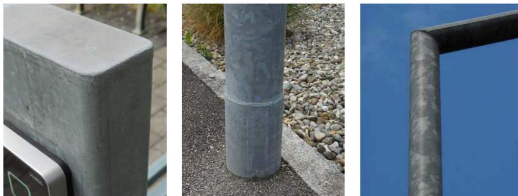
**Abbildung 4: Beispiele für geschlossene Hohlbauteile. Links: Metallposten. Mitte und Rechts: Detailaufnahmen von Schweißnähten an einer Straßenlaterne**
