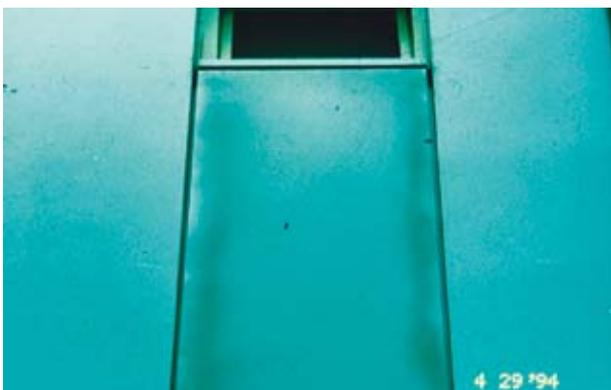
Bild 6: Bilderrahmeneffekt bei Metallic-Beschichtungen
