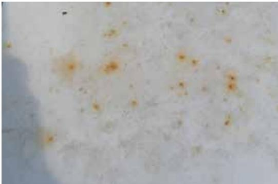
*Korrosionsschäden wegen zu geringer Schichtdicke*
